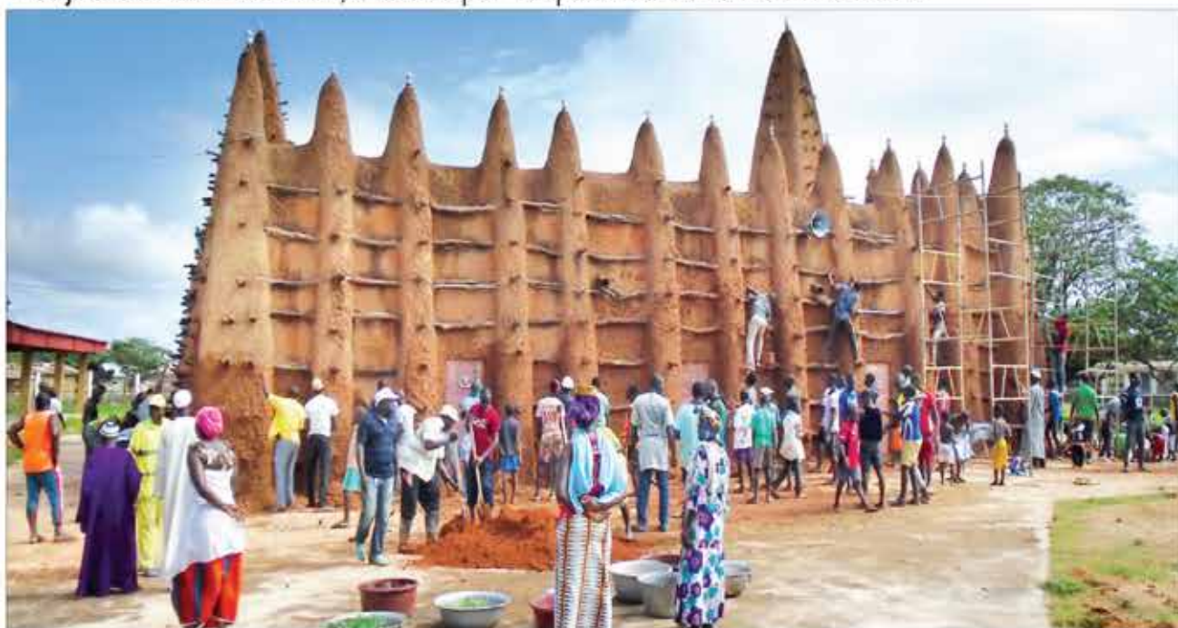
La grande mosquée de Kong, lors des travaux de réhabilitation lancés le 25 septembre 2022. Les grands travaux ont lieu une fois tous les deux ou trois ans.
