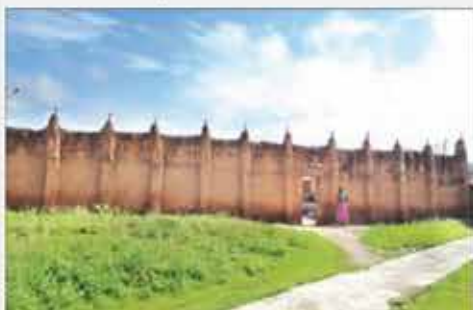
Egalement réalisé en terre battue, ici, le mur de l'historique université islamique.....
