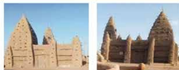
Photos de la petite mosquée de Kong après les travaux de réhabilitation Source : Secrétariat Exécutif de gestion des Mosquées de style soudanais du nord ivoirien
