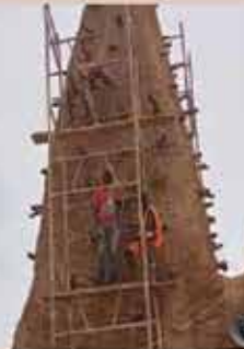
Photos illustrant les travaux d'entretien de l'enduit de la grande mosquée de Kong (Septembre 2022) Source : Secrétariat Exécutif de gestion des mosquées de style soudanais du nord ivoirien
