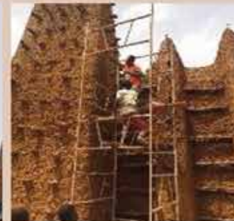
Photos illustrant les travaux d'entretien de l'enduit de la grande mosquée de Kong (Septembre 2022) Source : Secrétariat Exécutif de gestion des mosquées de style soudanais du nord ivoirien
