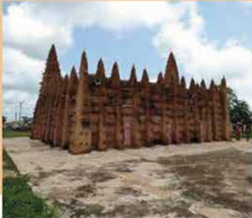
Photo montrant la grande mosquée de Kong avant les travaux (juin 2022)
