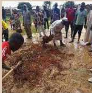
Photos illustrant les travaux d'entretien de l'enduit de la grande mosquée de Kong (Septembre 2022) Source : Secrétariat Exécutif de gestion des mosquées de style soudanais du nord ivoirien
