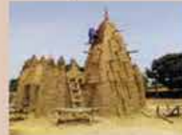
Photo illustrant la finition des travaux de réhabilitation de la mosquée de Kouto (février 2022)
