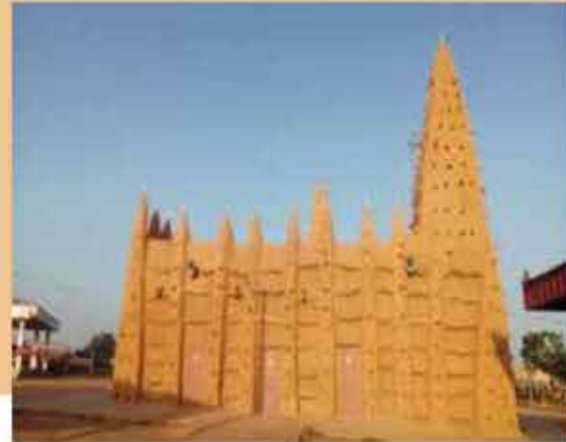
Photo de la grande mosquée de Kong après les travaux d'entretien (septembre 2022)
